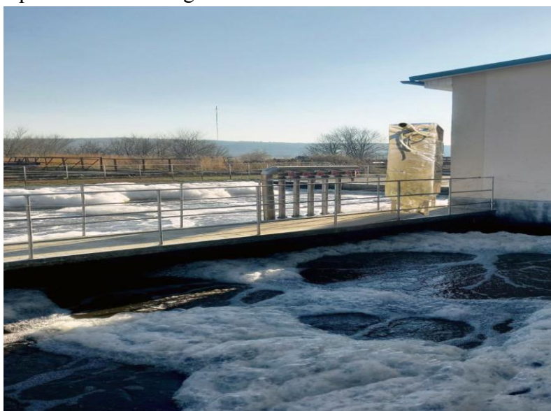
Fig. 1.5. Instalația pilot cuplată la sistemul de schimb de energie termică.
