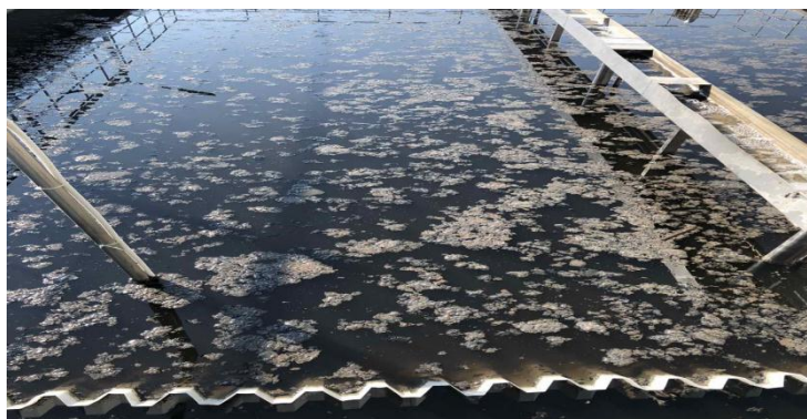
Fig. 1.7. Fenomenul parazitar de flotare a nămolului activ denitrificat la suprafața decantorului.
