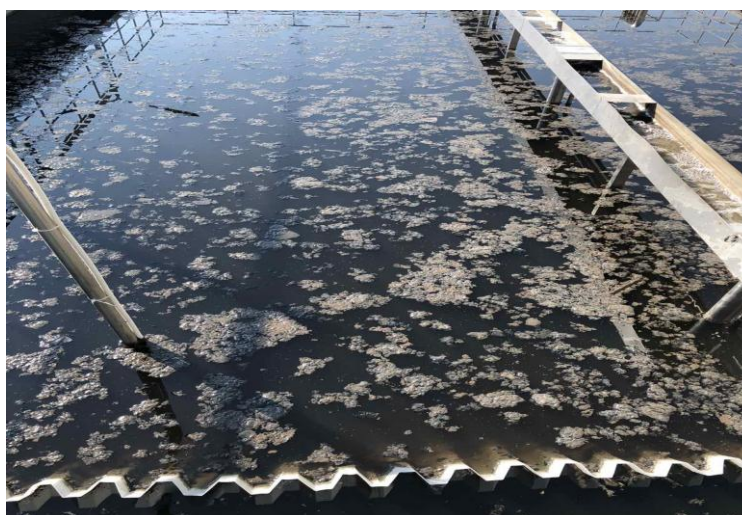
Fig. 7. Flotarea nămolului denitrificat în decantorul secundar (varianta 2)
