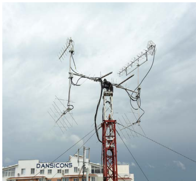
Fig. 2. Structura stației telemetrice de comunicații satelitare și clusterul ei de antene.
