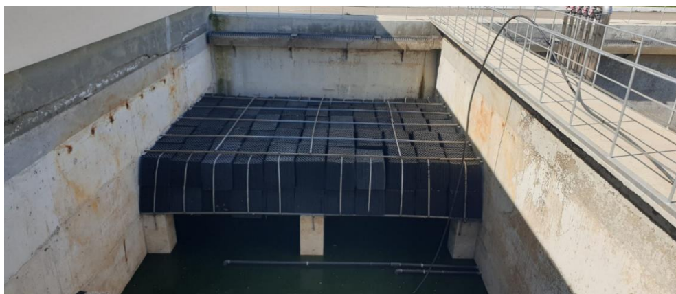
Figura 1. Unitate de biofiltru la stația de epurare a apelor uzate din orașul Căușeni
